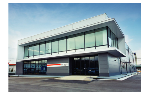
新開発センター New R&D Center
